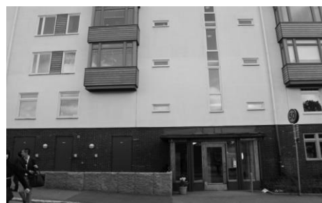
施設（集合住宅）外観
