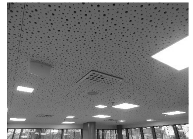
吸音ボード設置の天井
