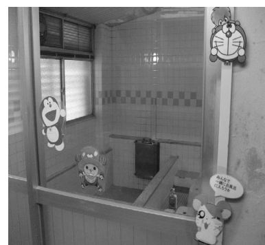
(写真5) 浴室シャワー
